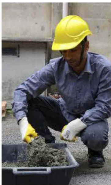
I ragazzi apprenderanno tecniche per lo svolgimento di piccoli lavori edili
